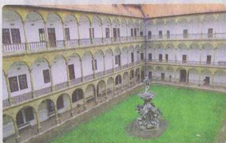
Rekonstrukce Bakchovy kašny na zámku v Bučovicích přijde na více než 2 miliony korun
